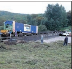
Ein 240 Tonnen schweres Bauteil wird auf der Weser verschifft.
